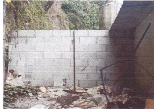
Foto 2: REPARACION DE MURO PERIMETRAL
